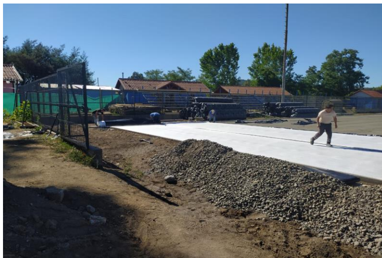
Inserción laboral. “Proyecto Mejoramiento Cancha de Futbol y Graderías Estadio Municipal de Portezuelo”
